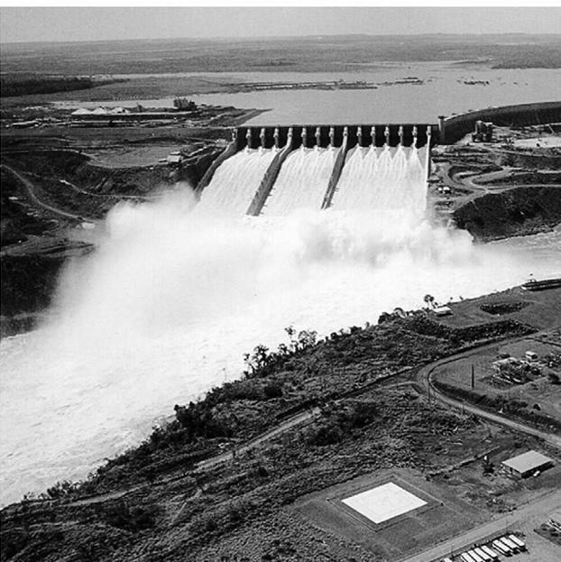
**Com a inauguração em 1982 de Itaipu, foi aberto o vertedouro, com uma vazão equivalente a 40 Cataratas do Iguaçu.**
